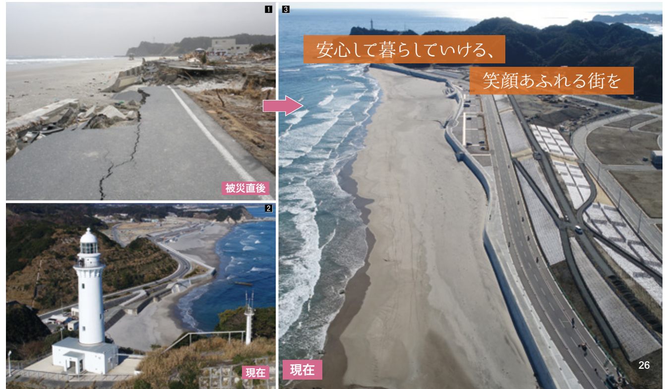
1 被災直後の薄磯地区海岸 2 塩屋崎灯台 3 薄磯地区
