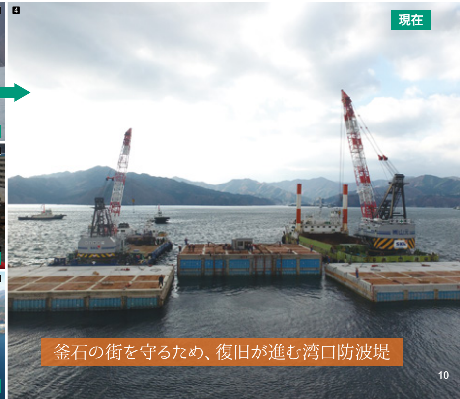
1 湾口防波堤(北堤)の被災状況 2 浜町高台より釜石港(須賀地区)方面(出典:岩手県建設業協会) 3 湾口防波堤(左が北堤、右が南堤) 4 ケーソン据付の様子
