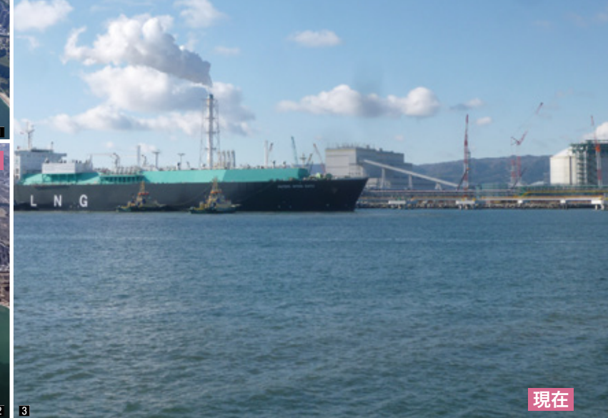
1 沖防波堤の被災状況(平成23年9月撮影) 2 沖防波堤の復旧状況(平成29年3月撮影) 3 LNG受入基地
