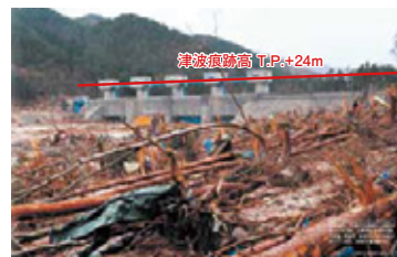
被災後の普代水門 出典：広報ふだい（平成23年3月号）
