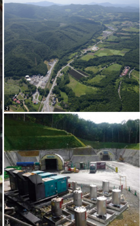
1 新区界トンネル(仮)内部 2 新区界トンネル(仮)宮古側坑口を望む 3 新区界トンネル(仮)宮古側坑口
