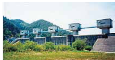
普代水門の全景
