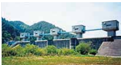
普代水門の全景
