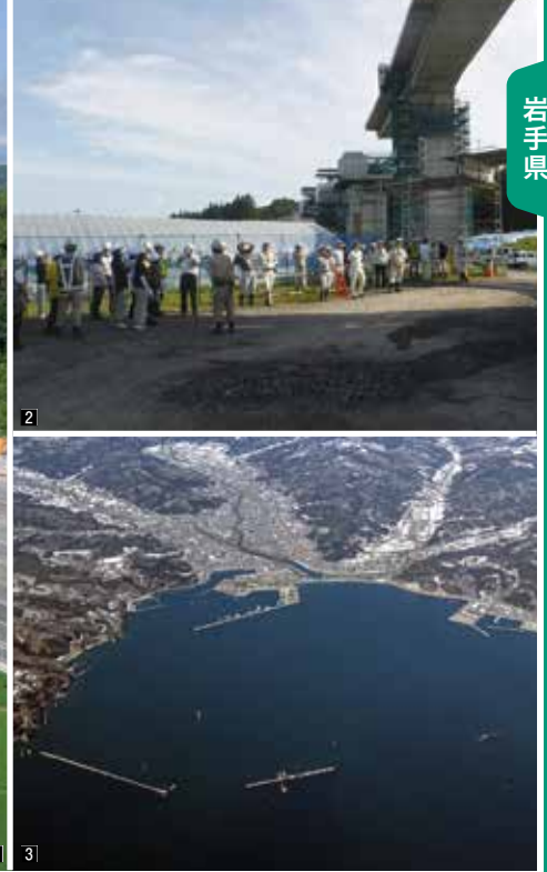
1 夏井高架橋(仮) 2 建設中の夏井高架橋(仮)を見上げる 3 久慈港全景
