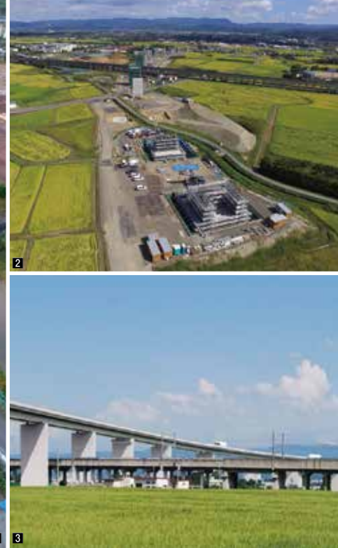
1 桑折高架橋(仮)の橋脚施工状況 2 桑折高架橋(仮)進捗状況 3 桑折高架橋(仮)完成イメージ図
