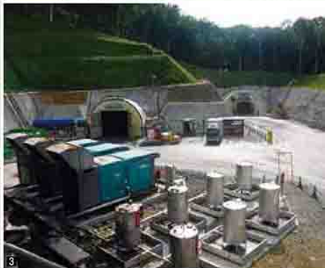
1 新区界トンネル(仮) 内部 2 新区界トンネル(仮) 宮古割峠口を望む 3 新区界トンネル(仮) 宮古割峠口
