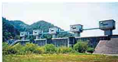
普代水門の全景
