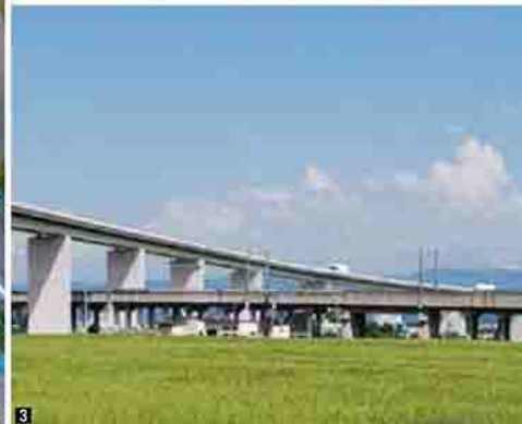
1 桑折高架橋(仮)の橋脚施工状況 2 桑折高架橋(仮) 蓋砂状況 3 桑折高架橋(仮) 完成イメージ図
