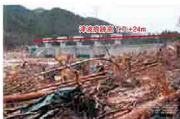
被災後の普代水門 出典：広報ふだい（平成23年3月号）
