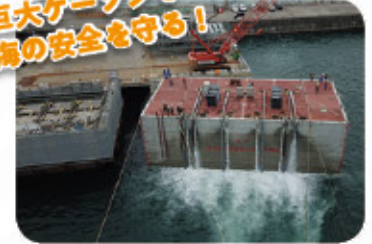
久慈湾湾口地区防波堤(北堤)築造工事(その3)
