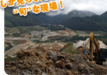
成瀬ダム堤体打設工事(第1期)
