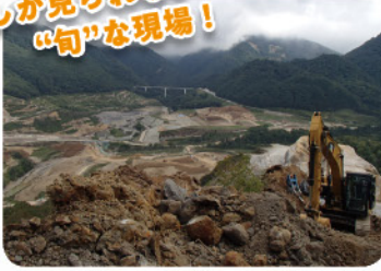
成瀬ダム堤体打設工事(第1期)
