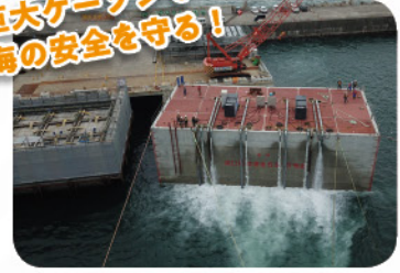
久慈港湾口地区防波堤(北堤)築造工事(その3)
