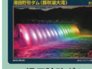
湯田貯砂ダム
