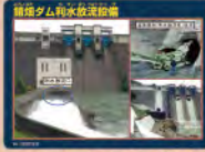
鍾畑ダム利水放流設備
