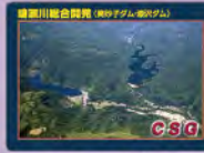
簡砂子ダム・漆沢ダム
