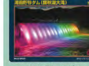
湯田貯砂ダム
