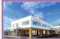
塩竈市津波防災センター
