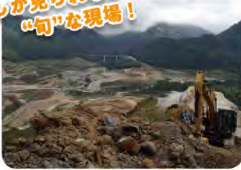
成瀬ダム堤体打設工事(第1期)
