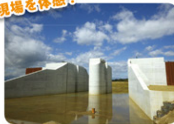
(一関遊水地長島水門新設工事)
