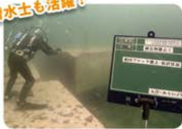
(むつ小川原港外港地区防波堤(東)(災害復旧)築造工事)
