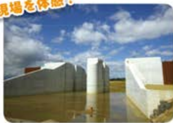
(一関遊水地長島水門新設工事)
