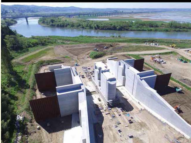
一関遊水地長島水門新設工事
