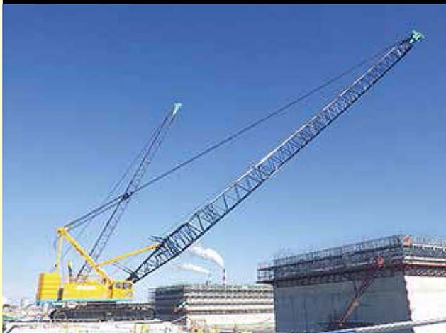
秋田港外港地区防波堤(第二南)本体工事
