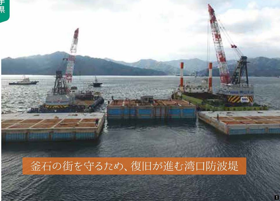
1 ケーソン据付の様子 2 釜石港全景 3 湾口防波堤(左が北堤、右が南堤) 4 赤灯台設置の様子
