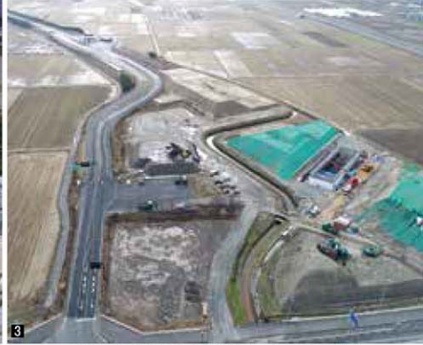
1 遊佐比子IC(仮)付近 2 地盤改良工事 3 酒田みなとIC付近
