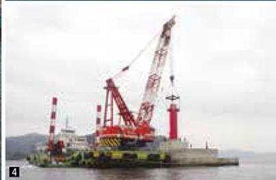
1 ケーソン据付の様子 2 釜石港全景 3 湾口防波堤(左が北堤、右が南堤) 4 赤灯台設置の様子
