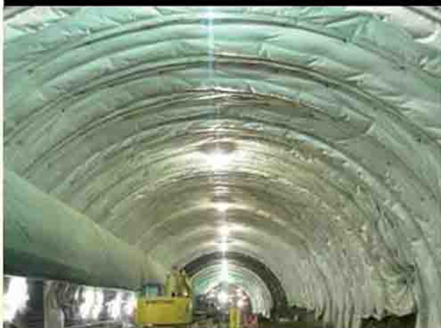
復興支援道路 相馬福島道路 国道115号 腰巡トンネル工事
