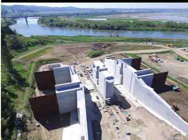
一関遊水地長島水門新設工事
