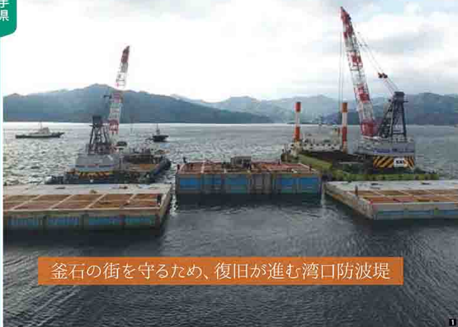
1ケーソン置付の様子 2釜石港全景 3湾口防波堤(左が北堤、右が南堤) 4赤灯台設置の様子
