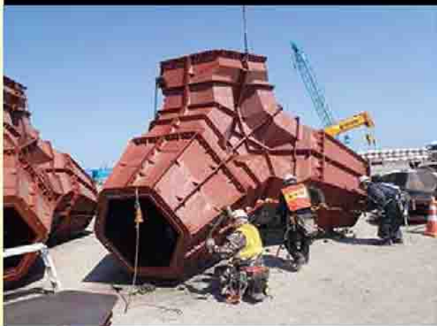
むつ小川原港外港地区防波堤(東)(災害復旧)築造工事
