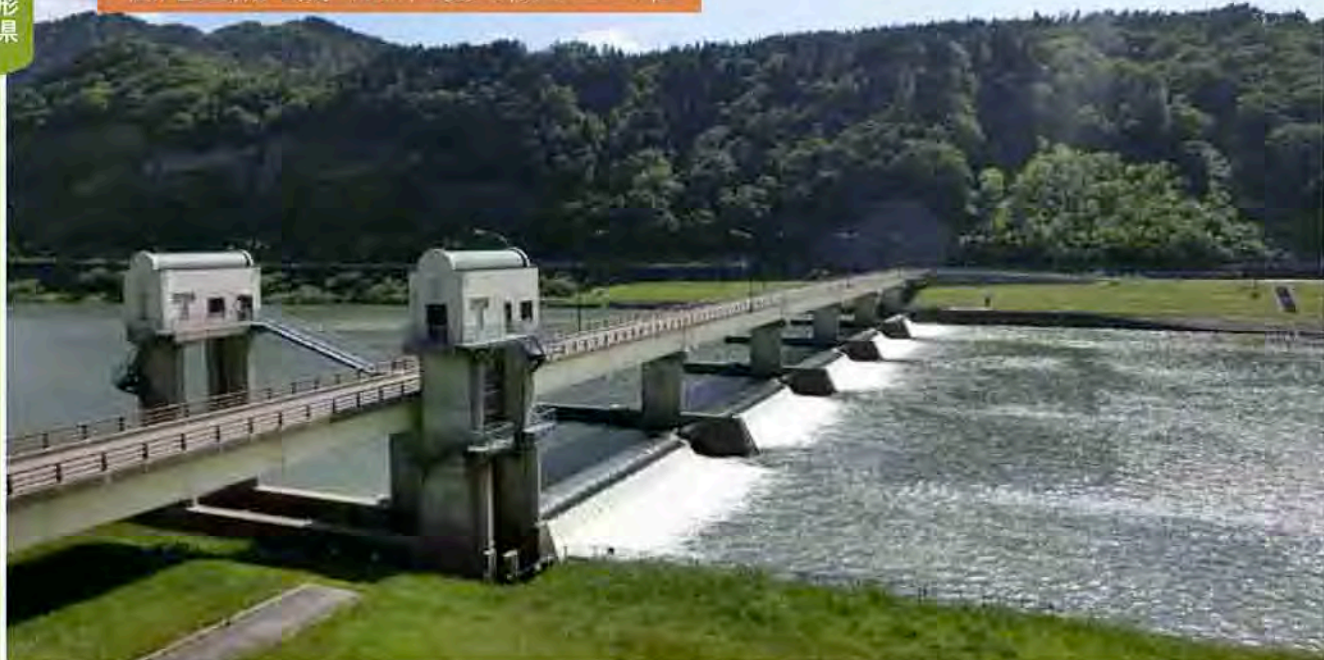
さみだれ大堰
