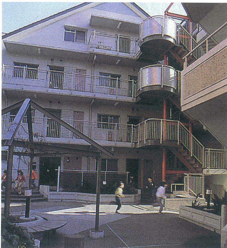
連鎖的に建て替えられた街並み（コープ愛宕：埼玉県上尾市）
