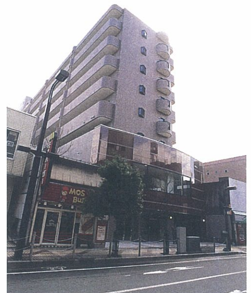
優建事業を活用したマンション
