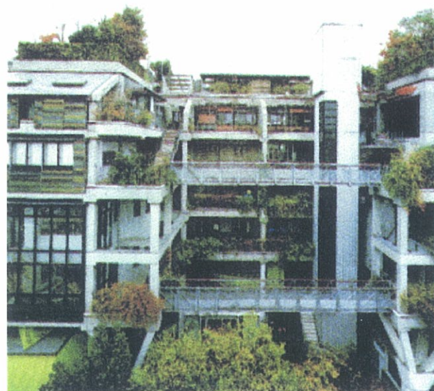
大阪ガス実験集合住宅 NEXT 21
