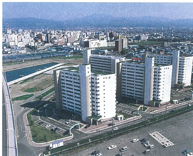
青森県営住宅：ベイサイド柳川（青森市）
