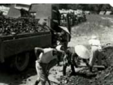
林道 (営林署) の敷砂利運搬作業
