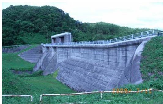
図 小羽広ダム
