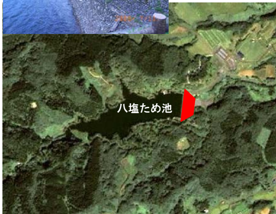
図 八塩ため池
