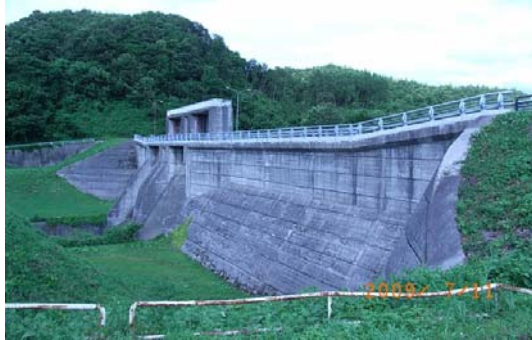
図 小羽広ダム
