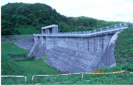
図 小羽広ダム
