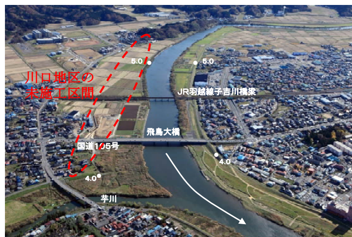
図 4.2-22 未施工区間の例 (川口地区)
