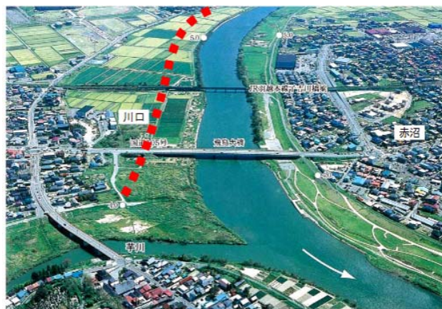
図 2.4-5 川口地区 堤防整備箇所
