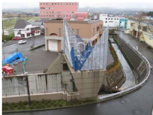
大沢川排水機場
