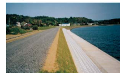
湖岸堤（霞ヶ浦開発、水資源機構）
