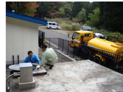
給水車による浄水場 着水槽への補給状況(平成20年 松ヶ崎簡易水道)
