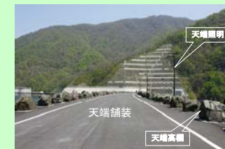
附属設備(天端舗装、照明)
