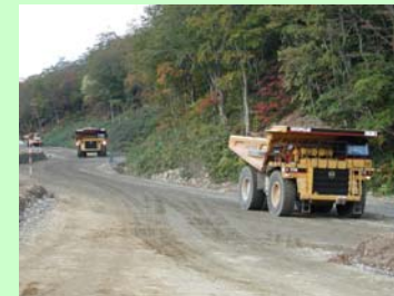
仮設備(工事用道路)
