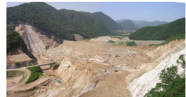
基礎掘削の例
