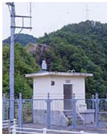
雨量観測所 (他ダム事例)
