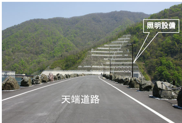
照明設備と天端道路（他ダム事例）
