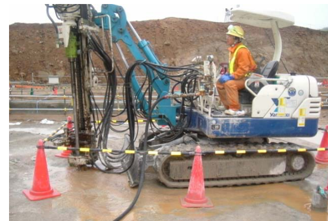
ボーリング状況 (他ダム事例)
