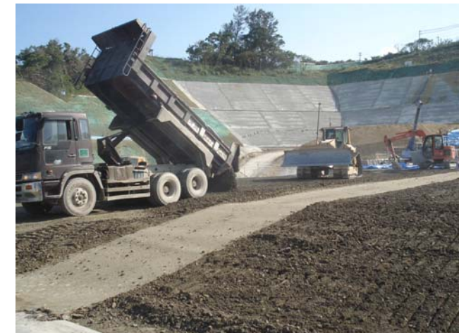
CSG施工状況(他ダム事例)
