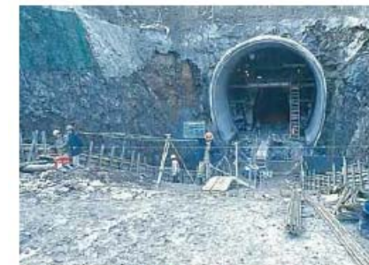
仮排水路トンネル呑口部
