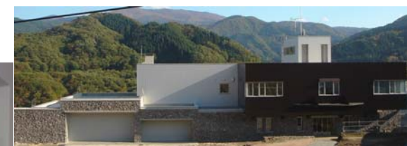
管理用事務所(他ダム事例)
