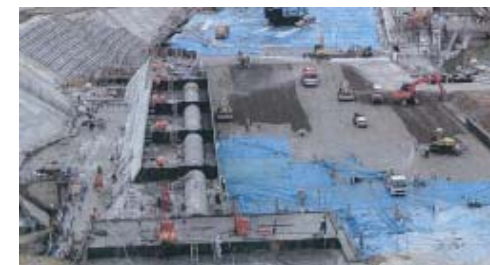
監査廊CSGダム (他ダム事例)
