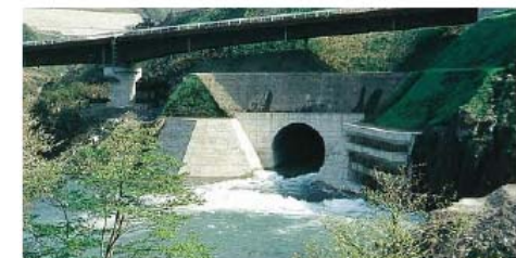
仮排水路トンネル吐口部
