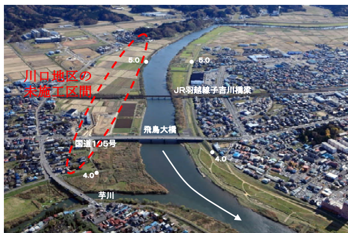
図 4.2-22 未施工区間の例（川口地区）
