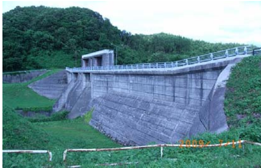
図 小羽広ダム
