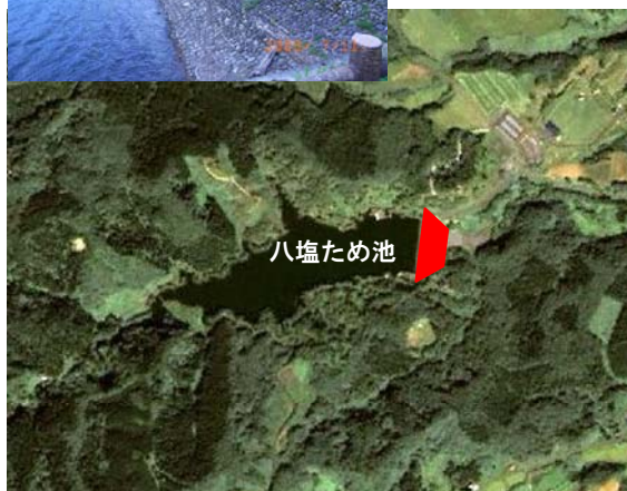
図 八塩ため池
