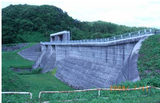
図 小羽広ダム
