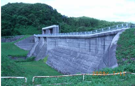
図 小羽広ダム
