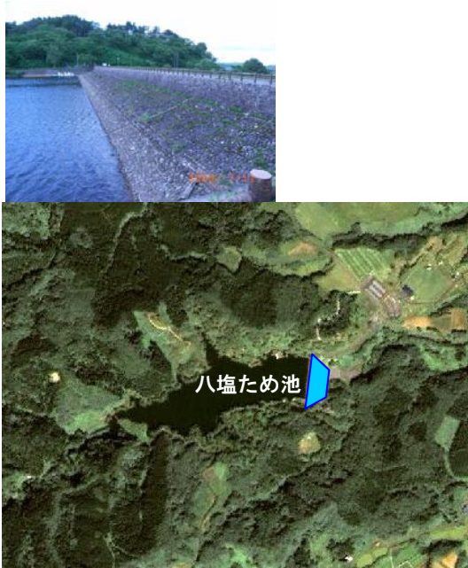
図 八塩ため池
