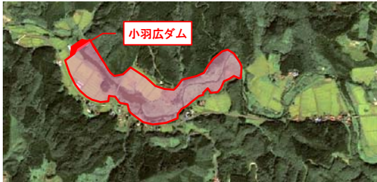
図 小羽広ダム
