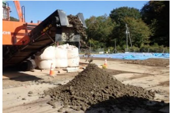
土質改良機によるCSG製造
