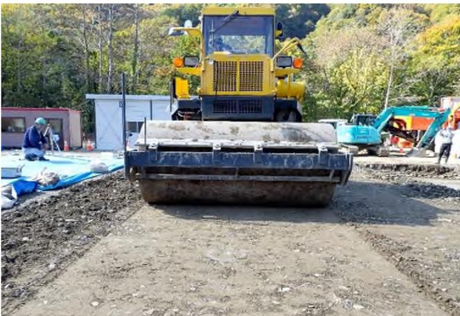
打設時の施工性確認(振動ローラによる転圧)
