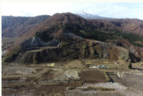
①左岸上部掘削施工状況
