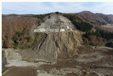
②右岸上部掘削施工状況
