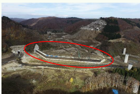
④仮締切(地中壁)施行状況(上流側)
