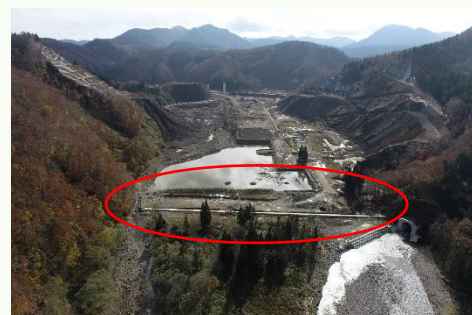
③仮締切(地中壁)施行状況(下流側)
