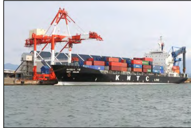
▲効率的で安全な荷役の実現 (外港1号岸壁:コンテナ取扱状況)
