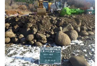
写真-4 掘削土砂 地中から掘り出した土砂(河床砂礫)です。
