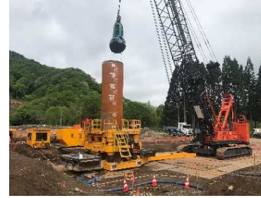
写真-3 掘削状況(ハンマークラブ) ケーシング内の土砂をハンマークラブで掘削します。
