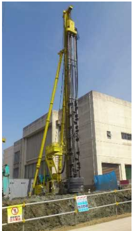
写真-1 削孔混練状況 ソイルセメントの壁を作るために孔を掘りながら、セメントスラリーを練混ぜます。
