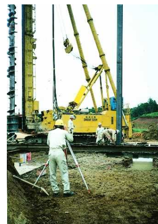
写真-3 芯材建て込み状況 地中壁を強くするために、芯材(H形鋼)を建込みます。
