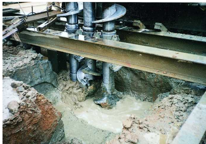
写真-2 混練状況(接写) セメントスラリーの練混ぜ状況です。
