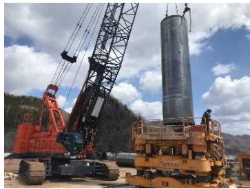
写真-1 ぜんぜんかいくつさくき 置換杭を掘るための機械を設置します。
