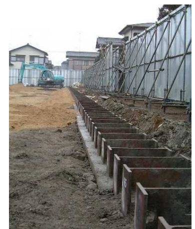
写真-4 芯材建て込み完了
