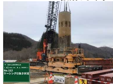
写真-6 ケーシング引抜 埋戻し後にケーシングを引き抜きます。
