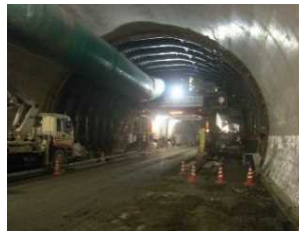
ロックボルト防護・シート張り・覆工【写真-5】
