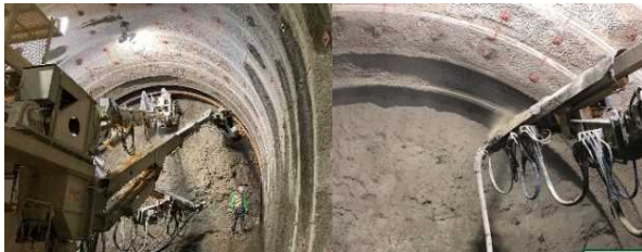
こうせいしほこう 鋼製支保工建込み・2次吹付作業状況【写真-4】
