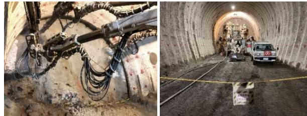
せんこう そうやく 穿孔・装薬状況【写真-2】 発破用の火薬を入れる孔を開けて、火薬を入れます。
