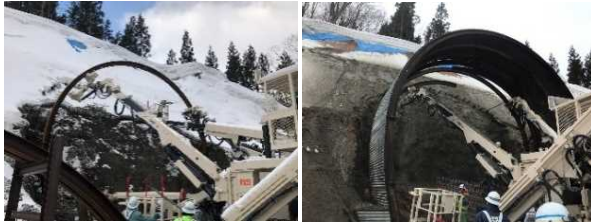
こうぐち 坑口付け【写真-1】 こうぐち 坑口を設置するための支保工を組み立てます。
