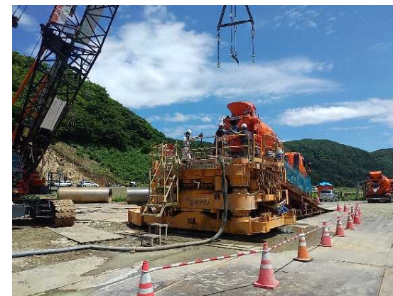
⑥ コンクリート打設【写真-3】
