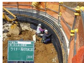
ライナープレート取付状況【写真-2】
