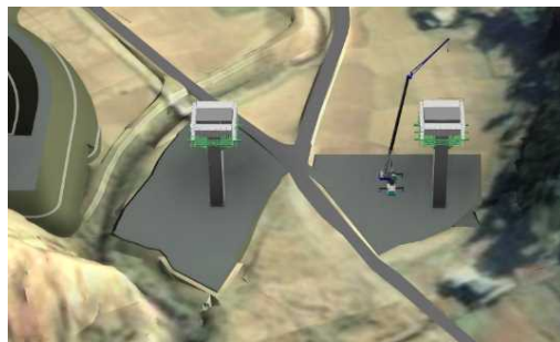
② 柱頭部工 (橋の桁【橋桁】を伸ばしていくための土台を作ります)
