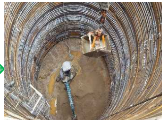
掘削状況【写真-1】
