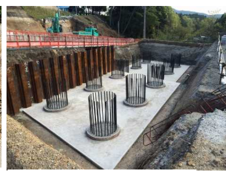
② 基礎材、均しコン打設完了
