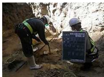
火薬装薬状況(岩の場所)
