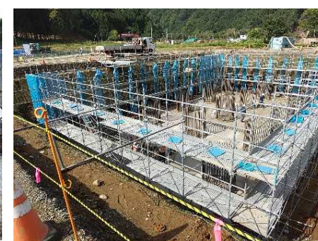
③ 足場組み立て状況
