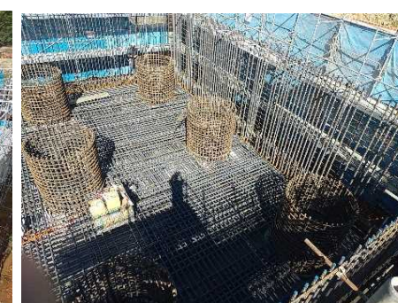
④鉄筋型枠組立状況
