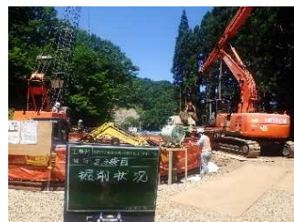
掘削状況【写真-1】
