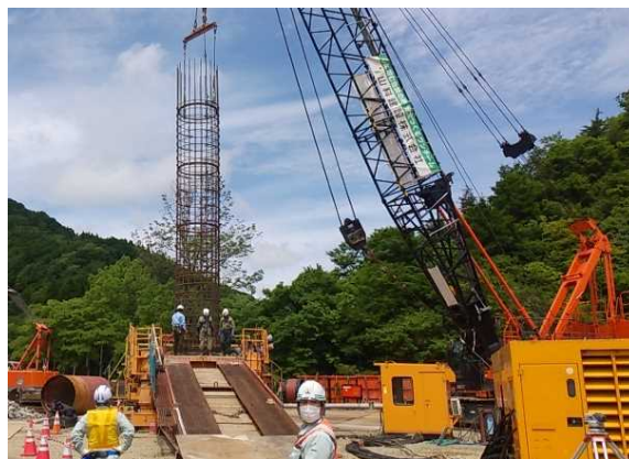
④ 鉄筋籠挿入【写真-2】
