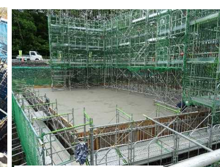
④生コン打設(イメージ)
