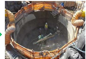
ロックボルト削孔【写真-3】
