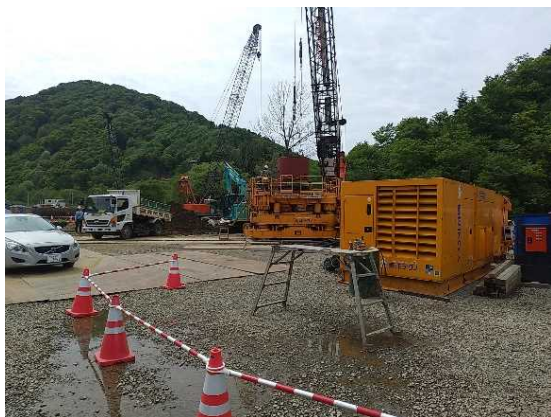
③ 掘削【写真-1】
