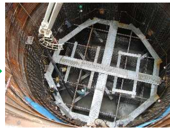
コンクリート打設状況【写真-5】
