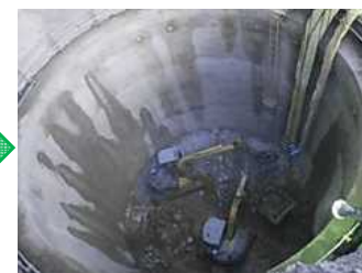
掘削はつり・ズリ搬出
