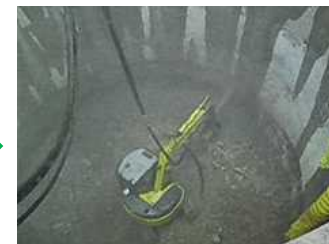
吹付コンクリート
