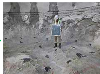
装薬・詰め物完了
