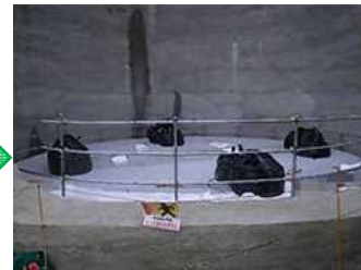
防護蓋設置完了
