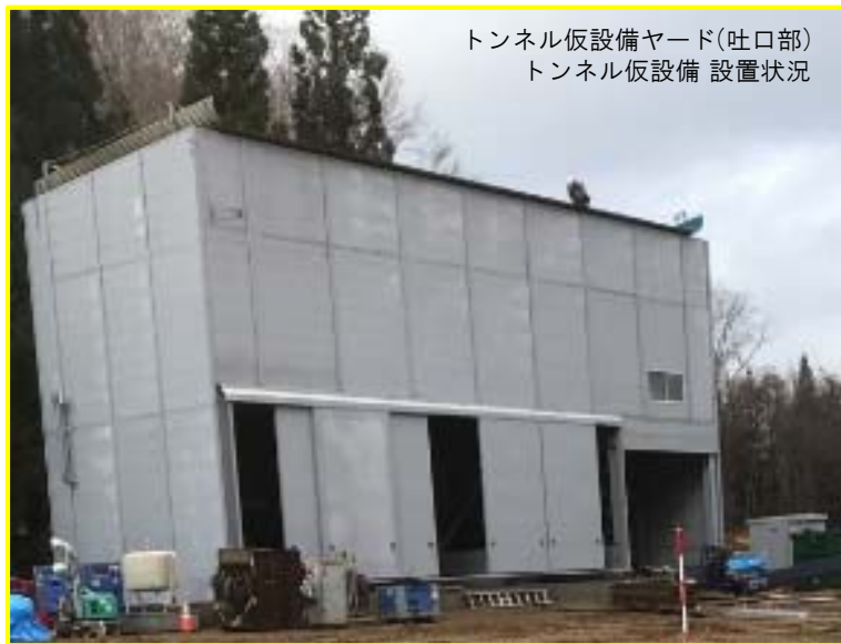
①仮排水トンネル工事
