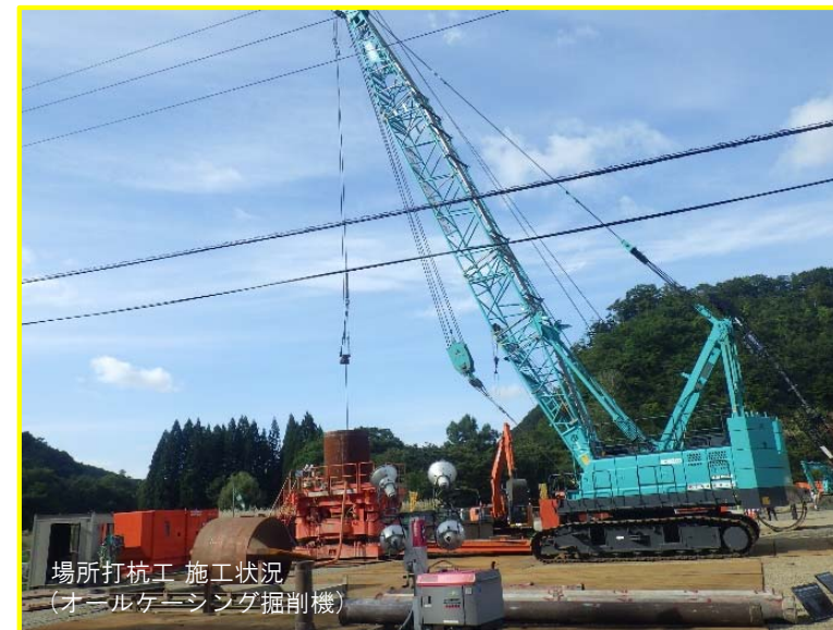
④4号橋下部工(P3)工事
