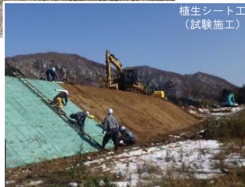
生態系に配慮した法面緑化
