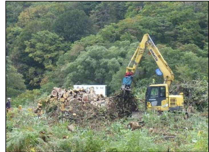
伐採木の処理状況 (仮締切(地中壁)工事)
