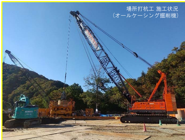
③4号橋下部工(P2)工事
