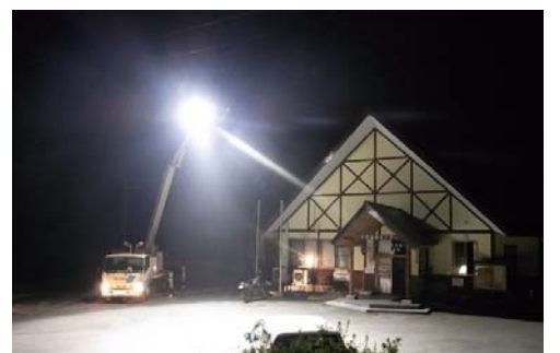
▲ 避難所への照明車設置
