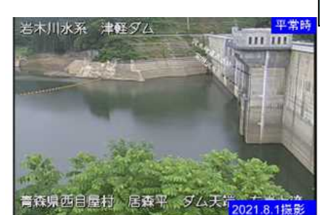
▲平常時の津軽ダム (CCTV)
