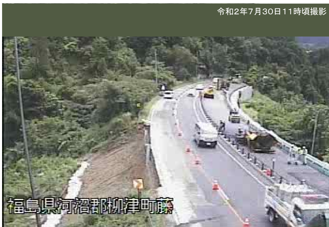
付加車線（工事中）の暫定利用に向けた舗装作業
