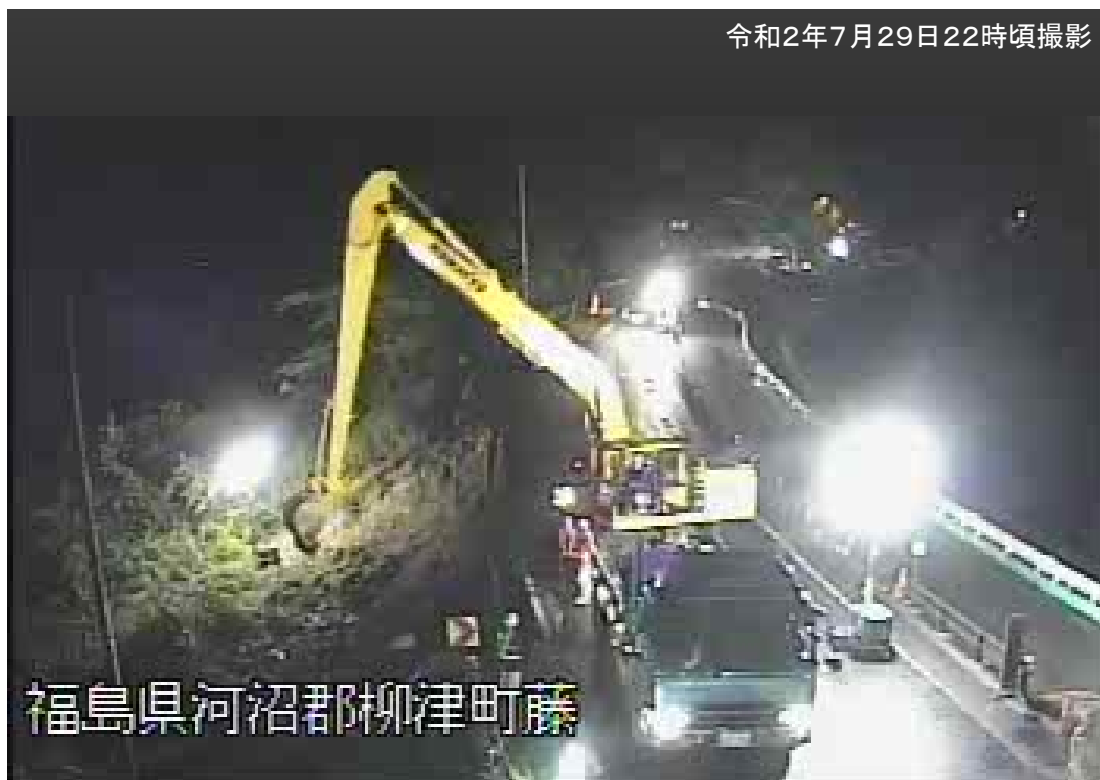
崩れた土砂の撤去作業
