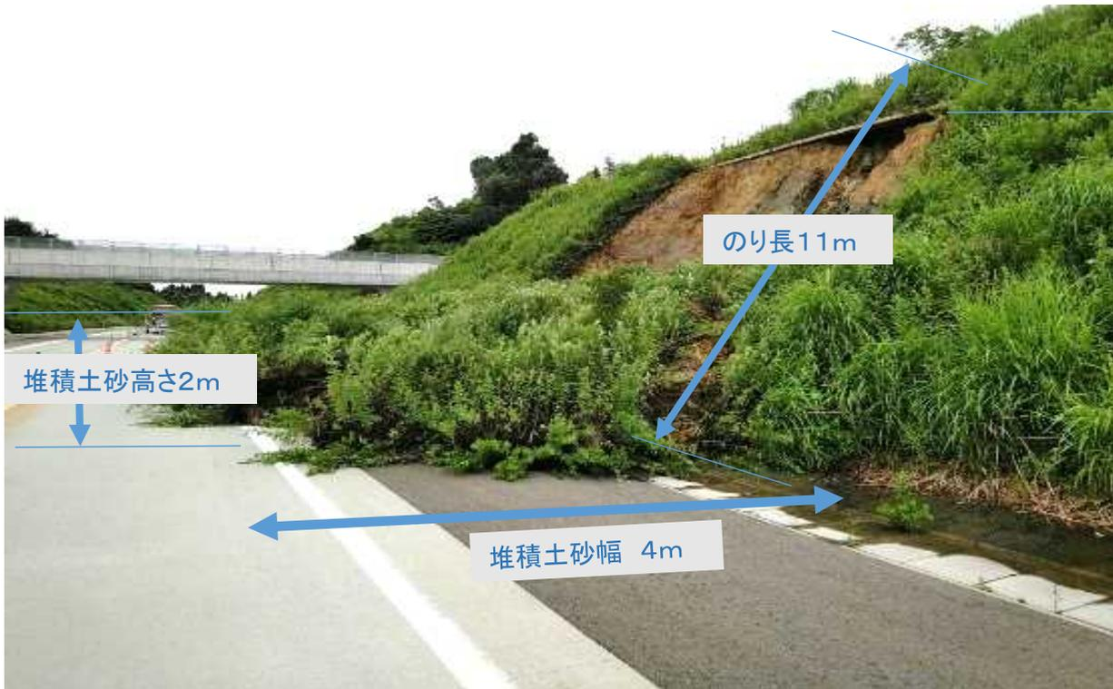
堆積土砂 体積 = 約140 m<sup>3</sup>
