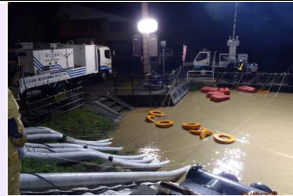
H25 低気圧降雨 山形県戸沢村 蔵岡地区
