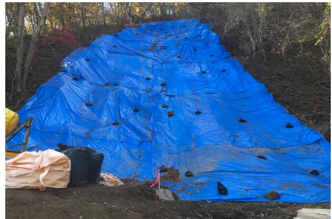
相馬福島道路(9.75kp(下り)) 2019.11.21 6時00分 侵食防止シート設置完了
