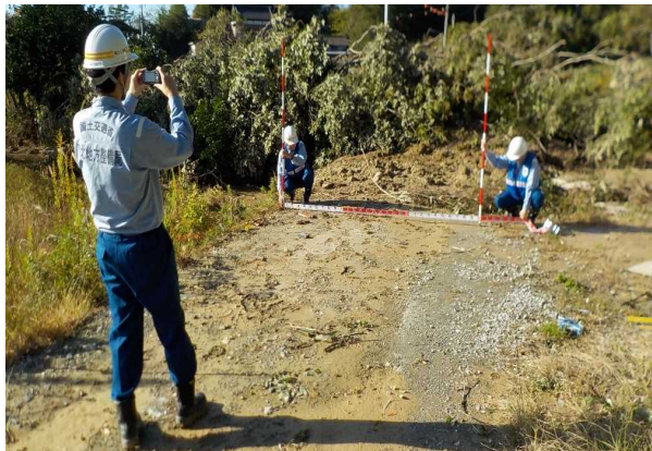
▲ 道路被災状況調査
