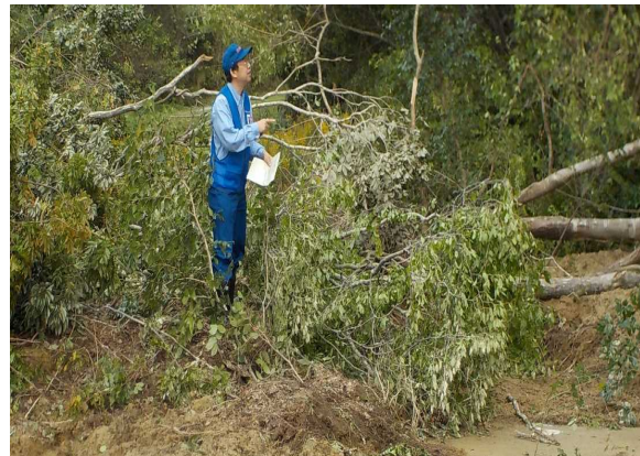
▲ 道路被災状況調査
