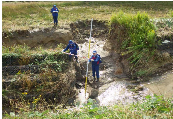
▲ 河川被害状況調査
