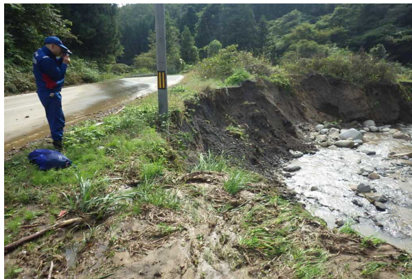
▲ 河川被害状況調査
