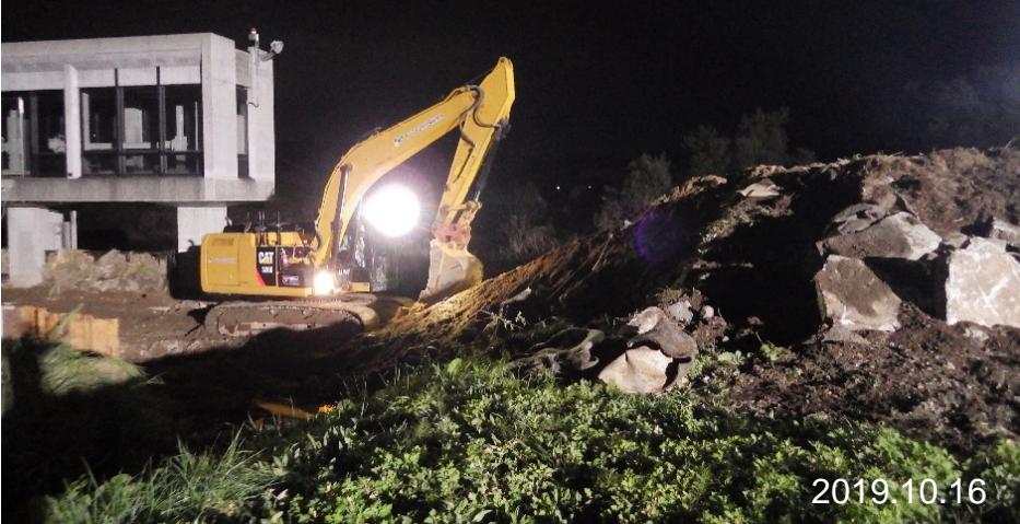
支障物撤去状況
