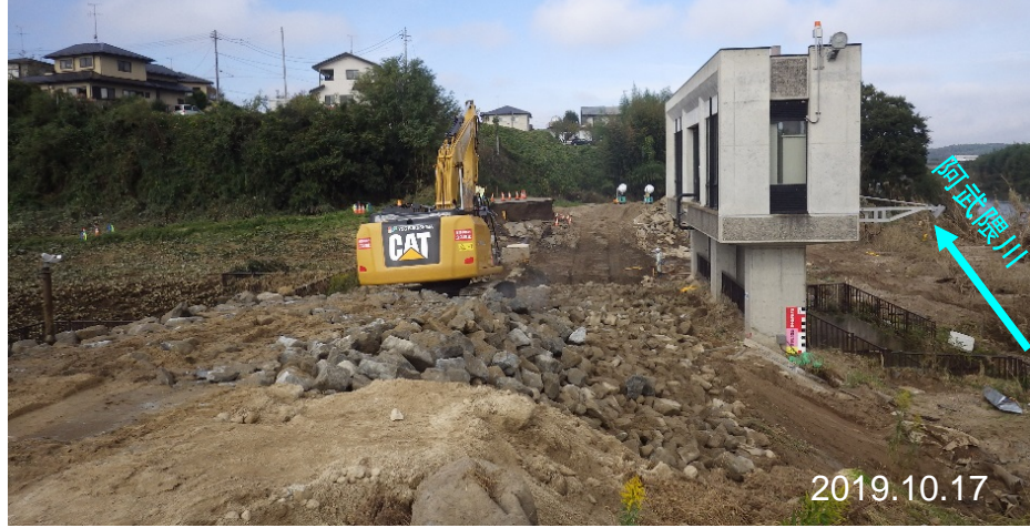
仮堤防施工状況
