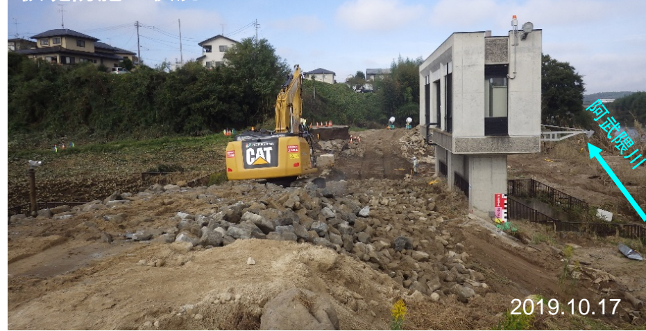
仮堤防施工状況
