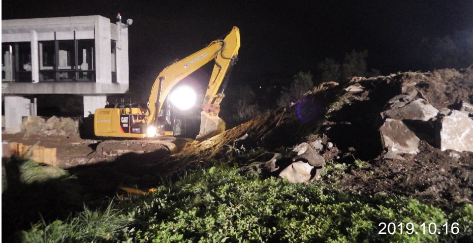
支障物撤去状況
