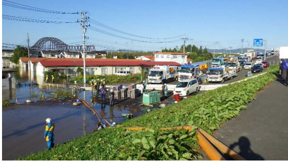
▲排水ポンプ車の配備状況
