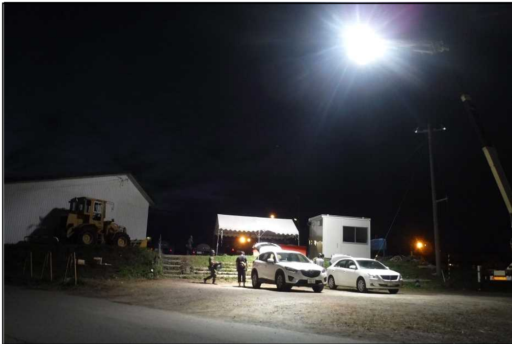
照明車稼働状況
