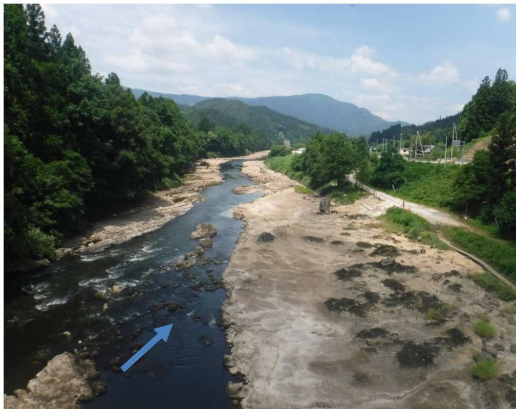
菖蒲観測所（白鷹町）付近の河川状況（H20.7.26撮影）
