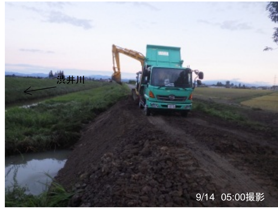
西荒井上流工区 復旧状況
