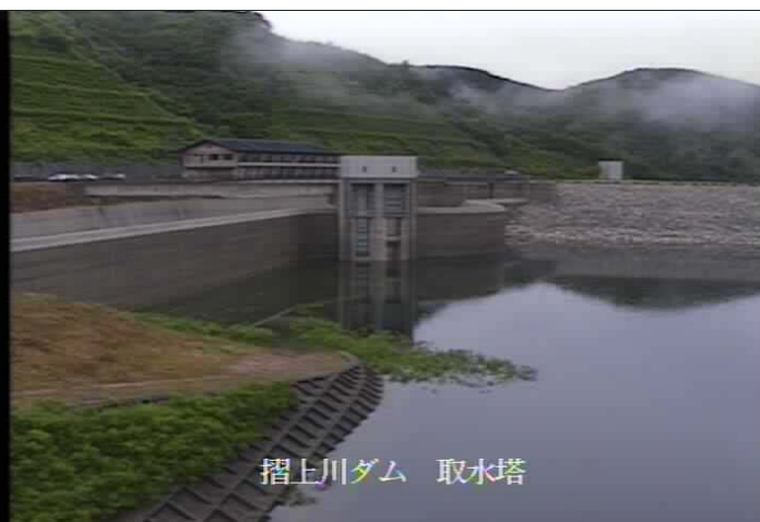
降雨開始から貯水池の水位が約1.5m上昇しました。
