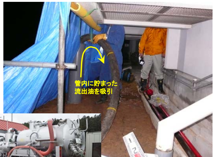
流出油の回収作業状況
