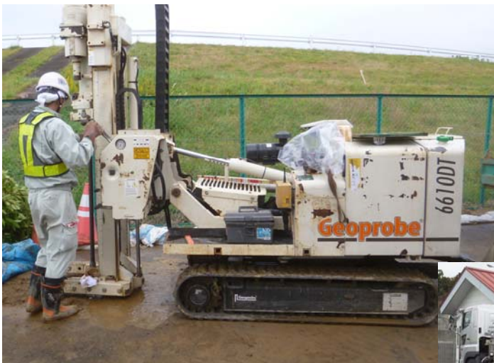
調査ボーリング状況
