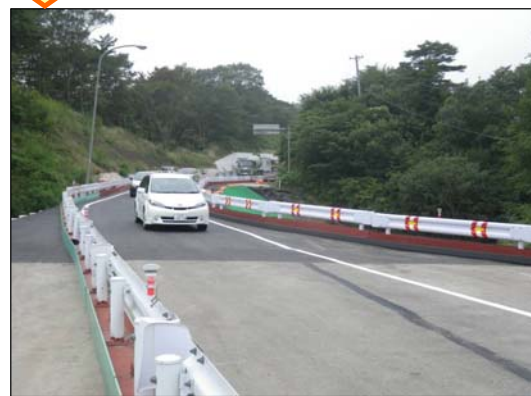
【8／3 1片側交互通行の状況】
