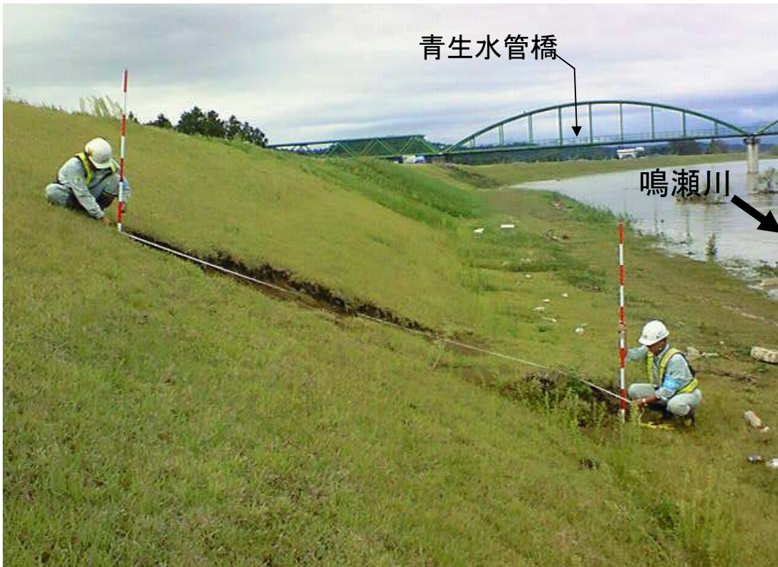
堤防被災 法面の崩れ
