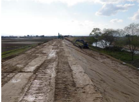
復旧盛土 4月25日撮影
