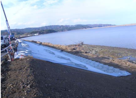
連結ブロック張り 4月25日撮影
