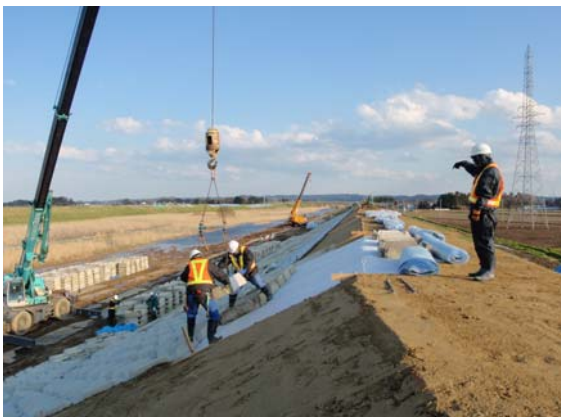
連結ブロック張り 4月25日撮影
