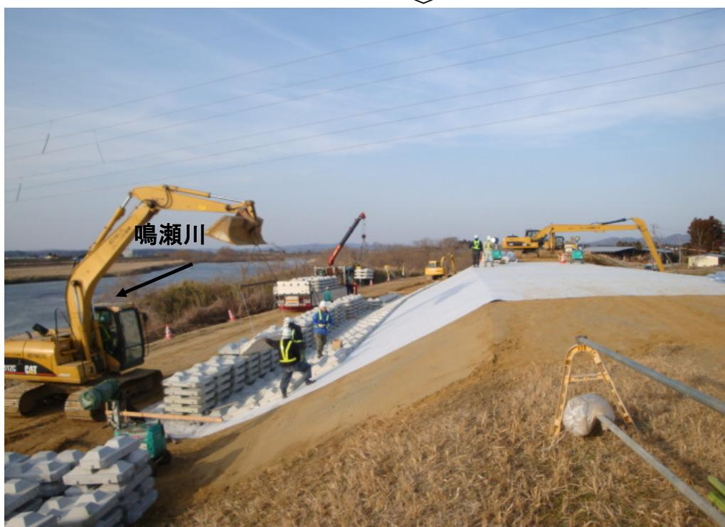
4月1日 堤防の復旧状況 堤防沈下の復旧盛土完了。
