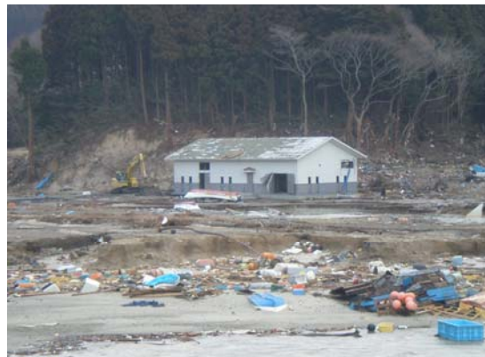
防波堤の周辺状況(その3)
