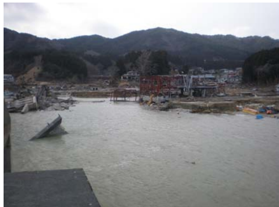
防波堤の周辺状況(その1)
