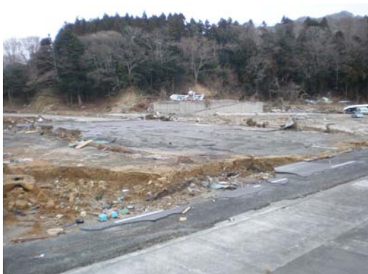
防波堤の周辺状況(その2)
