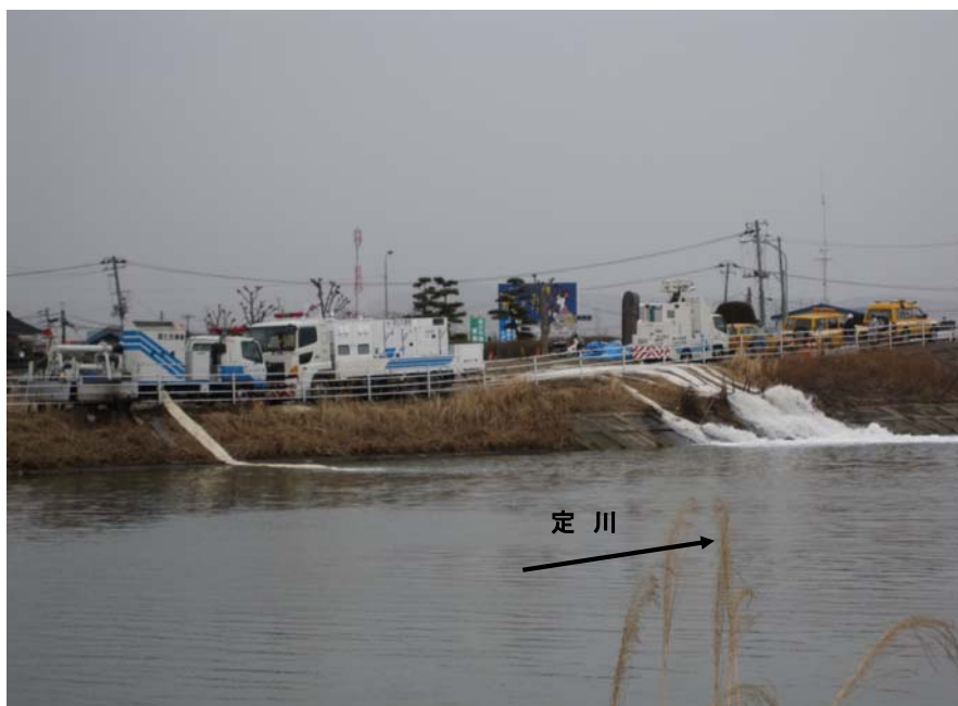
東松島市赤井(定川橋上流)で浸水解消のための排水状況 ※20日15時頃撮影
