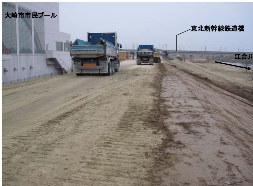
3月20日17時頃 堤防亀裂・沈下の復旧盛土
